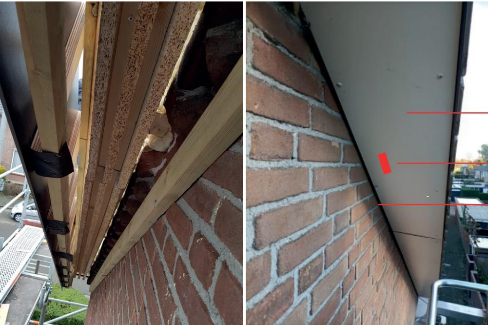
Figuur 3-34 Foto's van de constructie van de vleermuisvoorzieningen tijdens de herstelwerkzaamheden voor de gierzwaluwvoorzieningen in 2022 in cluster 2127, Oisterwijk. Door de uitstekende stenen van de buitenmuur kon de vleermuisvoorziening blijkbaar niet tegen de buitenmuur aan gemonteerd worden (foto links waar het trespa verwijderd is). Aan de buitenzijde zijn er geen openingen in het trespa aanwezig en is de kier met de buitenmuur afgedicht door de gemonteerde balk (foto rechts).
