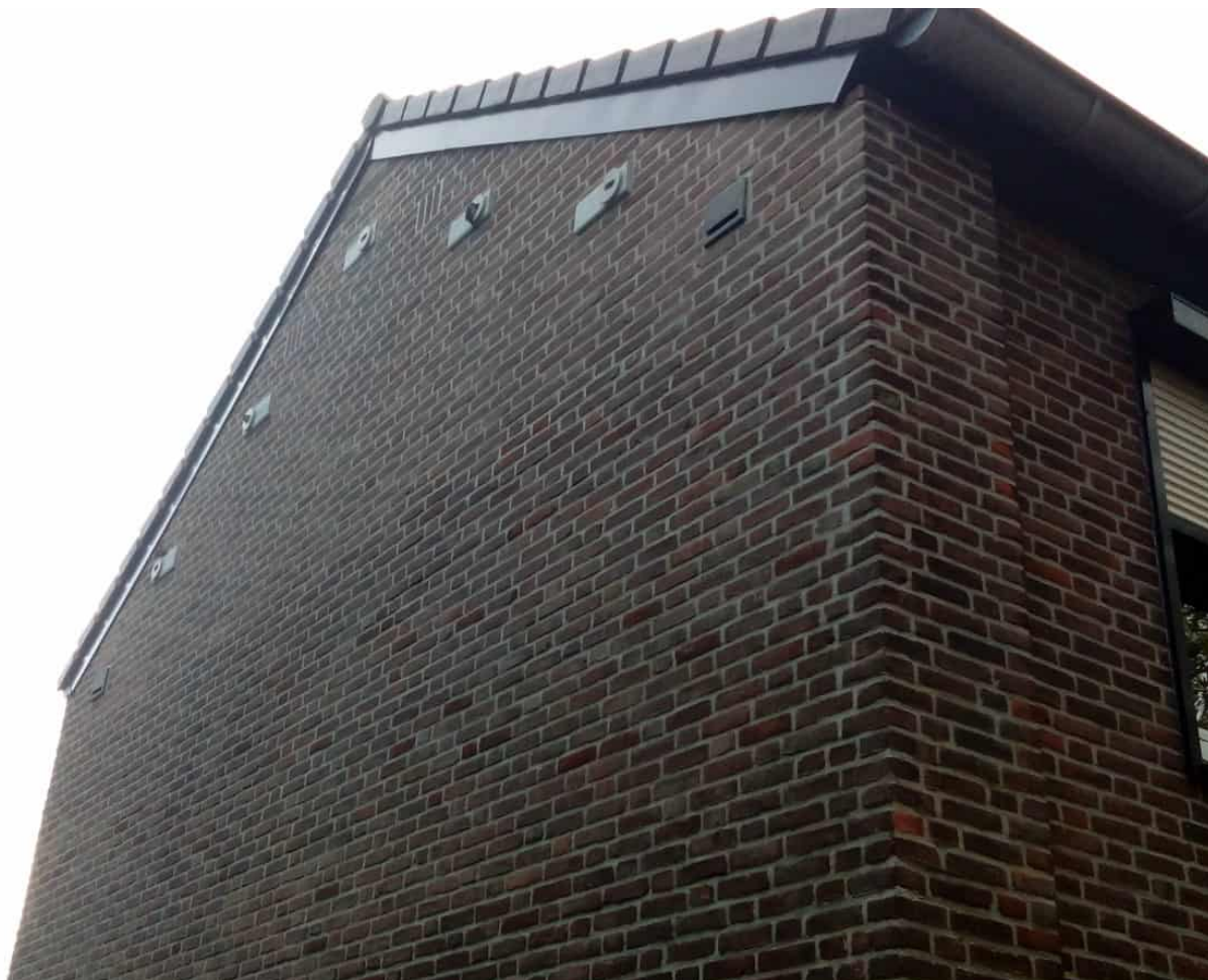
Schwegler gierzwaluw nestkast type 17 (lichtgrijs) bewoond door huismus. Op de foto zijn ook entreestenen naar vleermuisverblijven van Vivara Pro (donkergrijs) zichtbaar. Let op: bij Schweglerkasten kunnen soms dopjes van de kasten rond invliegopening loskomen (Bron: Arcadis)
