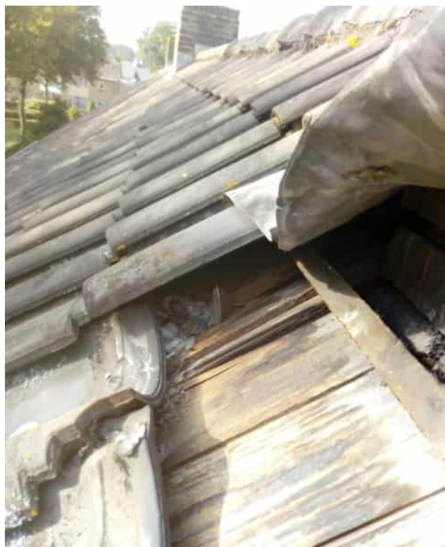
Voorbeeld gierzwaluwnest onder dakpannen. In dit geval toegang via kantpan of loodslab bij schoorsteen. Project St. Joseph in Boxtel (Bron: Arcadis)
