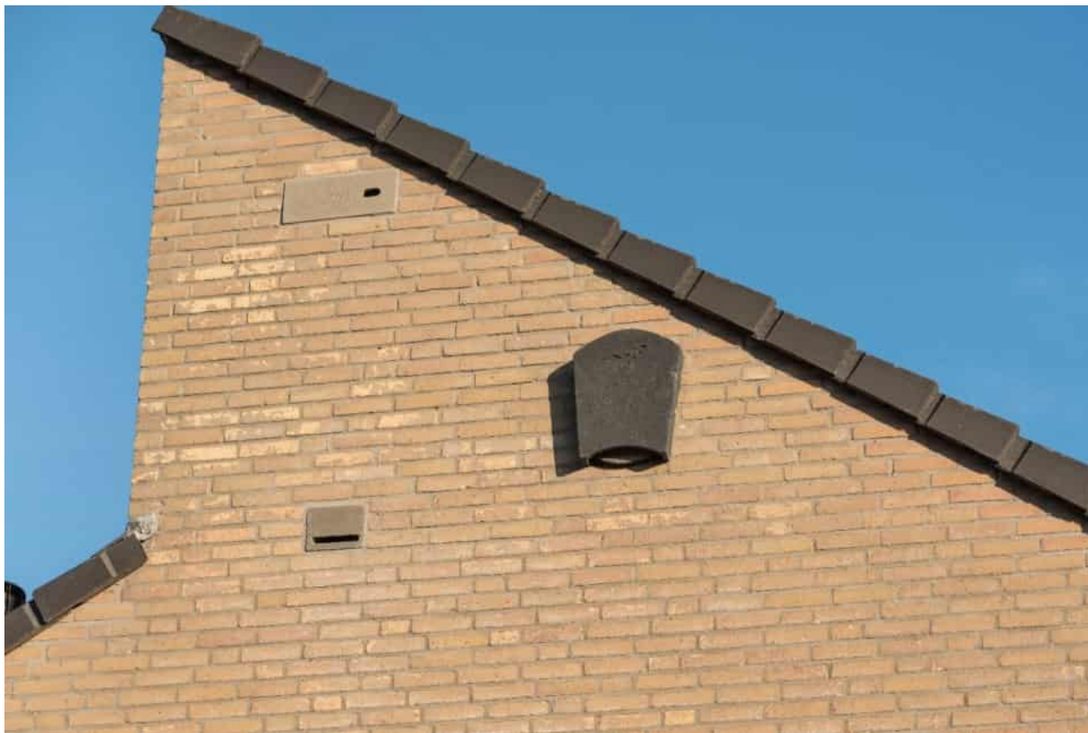
Entresteen ingebouwd (links onder) in combinatie met een inbouwkast gierwaluw en een opbouw vleermuiskast (tijdelijke mitigatie) (Bron: Vivara Pro)
