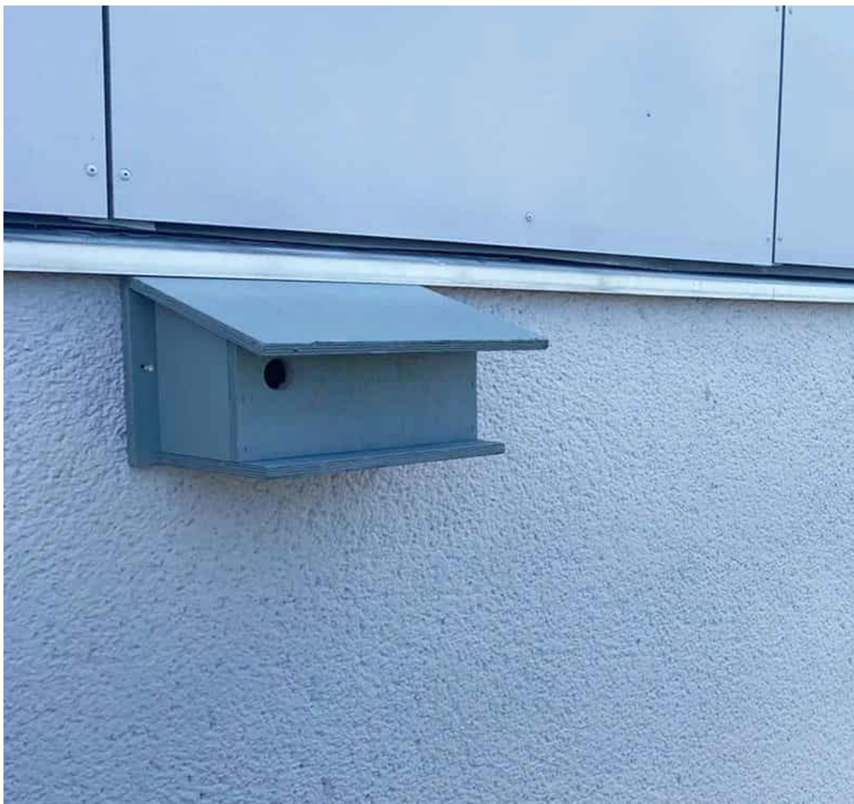
Voorbeeld houten (multiplex) opbouwkast voor de huismus van Unitura HMT1 (bron: Unitura.nl)
