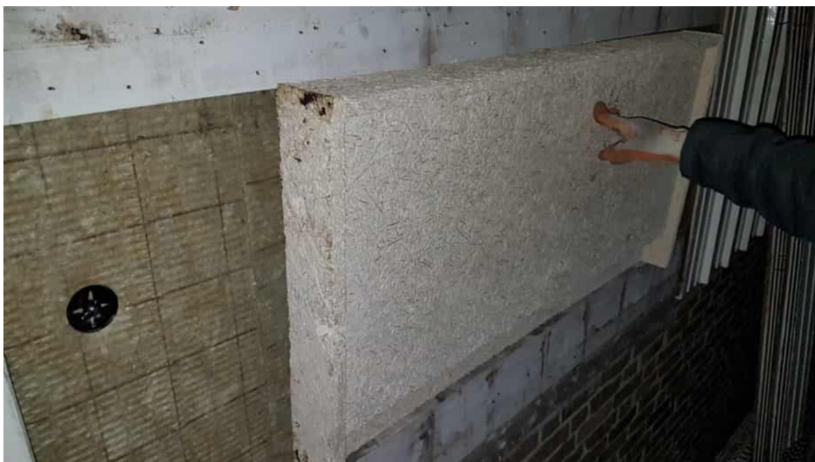
Vleermuisverblijf achter houten betimmering gecombineerd met een op maat gemaakte inbouwkast welke vanachter de gevelbeplating toegankelijk was voor vleermuizen, Breeakkers te Son, Woonbedrijf Eindhoven. (Bron: Arcadis)
