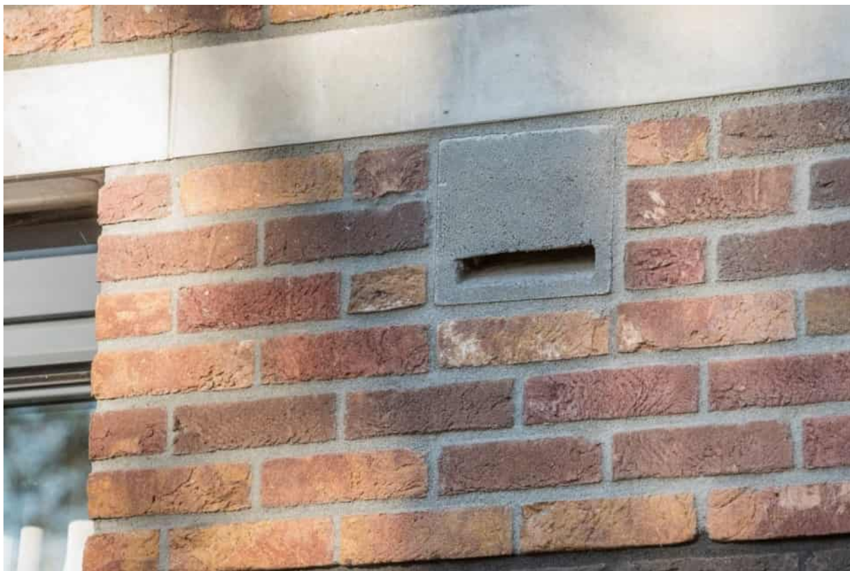
Entresteen in een spouwmuur (Bron: Vivara Pro)
