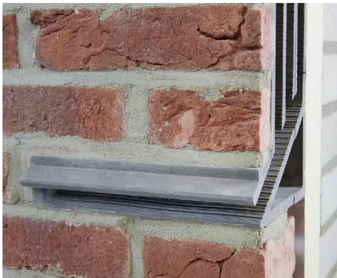
Ingebouwd Tichelaar prefab verblif. Voorbeeld geschikt als kraamverblijfplaat (Bron: Koninklijke Tichelaar Makkum)
