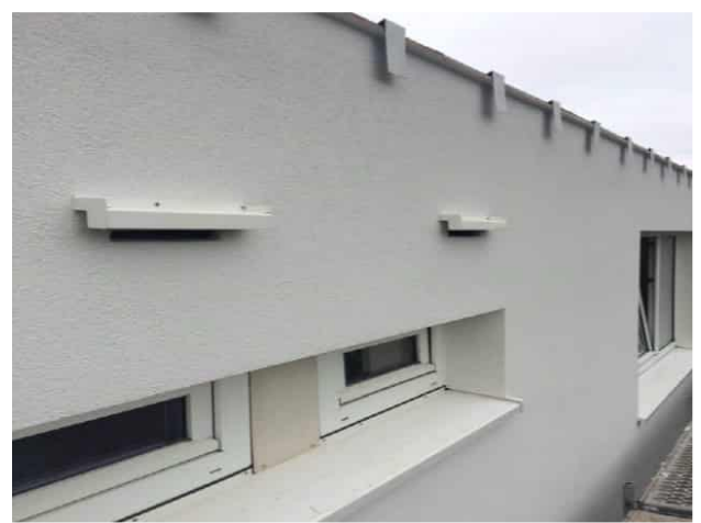
Voorbeeld vleermuisverblijf in de voorgevel. Hierbij is gebruik gemaakt van twee lagen en zijn verschillende compartimenten onderling met elkaar verbonden. (Let op dat er voldoende ruimte is tussen dak en uitvliegopening in verband met predatie vanaf het dak) (Bron: Arcadis)
