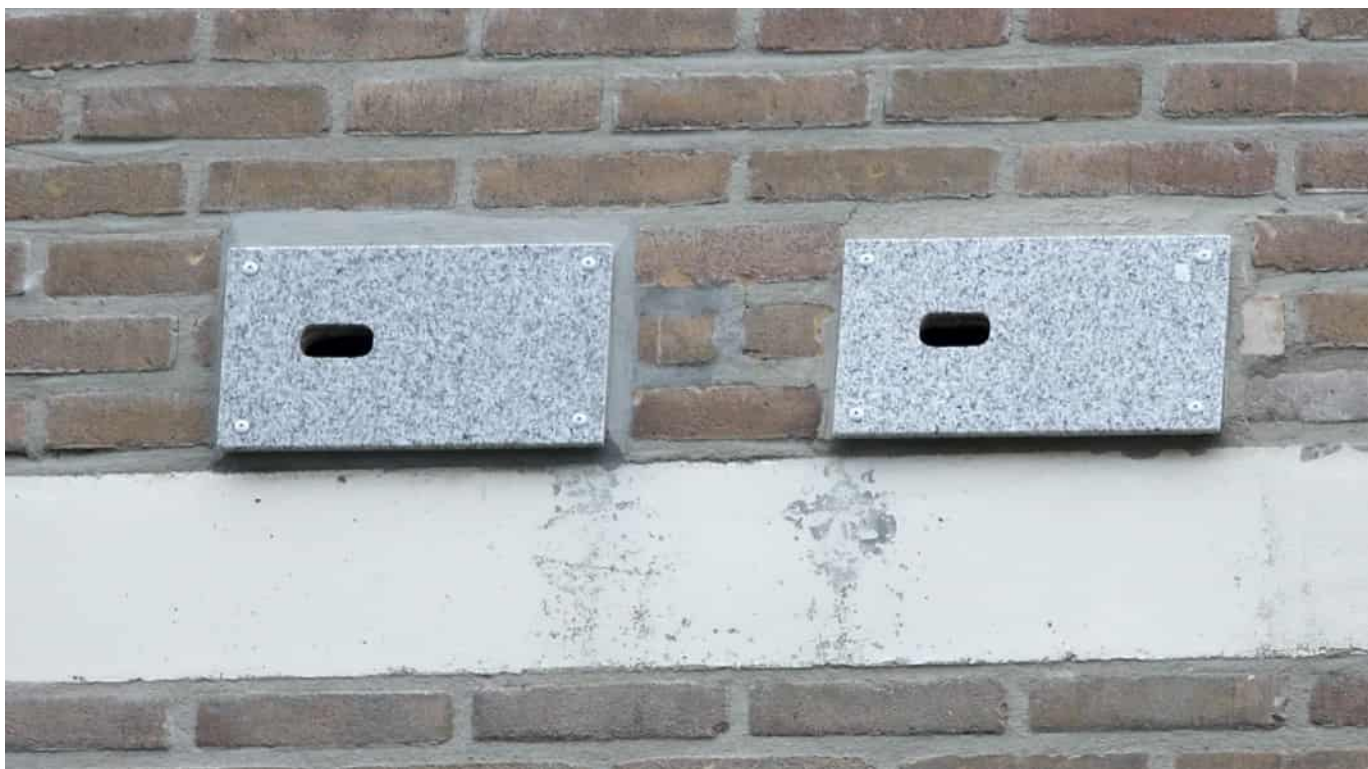
Halsbandparkieten die gierzwaluwkasten kraken, Als oplossing kan een marmerenplaat toegevoegd worden over de kasten (Bron: Vivara Pro)
