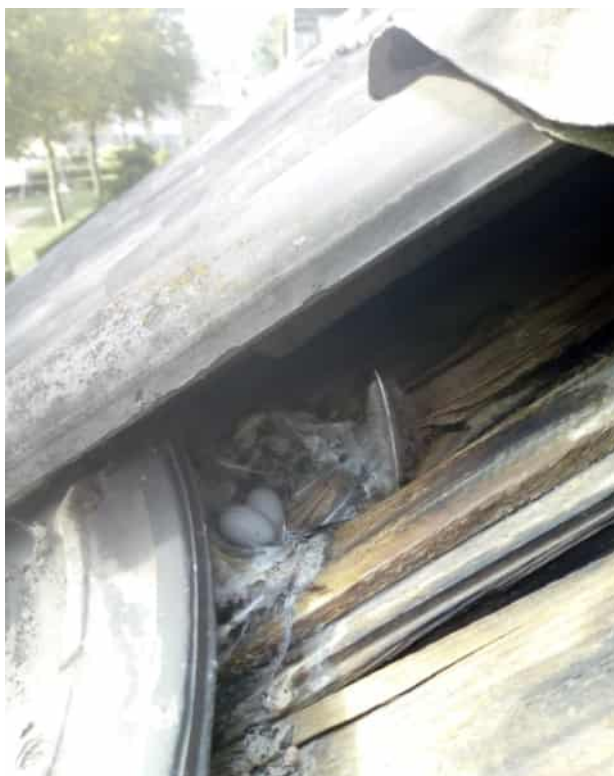
Voorbeeld gierzwaluwnest onder dakpannen. In dit geval toegang via kantpan of loodslab bij schoorsteen. Project St. Joseph in Boxtel (Bron: Arcadis)
