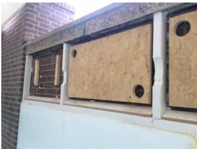
Voorbeeld vleermuisverblijf in de voorgevel. Hierbij is gebruik gemaakt van twee lagen en zijn verschillende compartimenten onderling met elkaar verbonden. (Let op dat er voldoende ruimte is tussen dak en uitvliegopening in verband met predatie vanaf het dak) (Bron: Arcadis)
