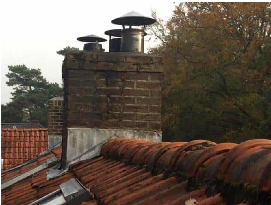
Voorbeeld schoorsteen met loodslab (Bron: Werkspot.nl)
