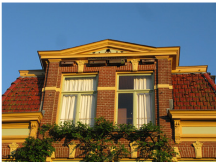
Het huis van Jan Doevendans. Op de foto is te zien dat er naast de 4 nestkasten en 10 invlieg dakpannen ook nog in het timpaan (halve boog of een boogdeel boven een deur) invlieg openingen zijn aangebracht van verschillend formaat voor andere vogels dan gierzwaluwen.
